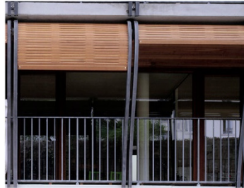
Black metal balustrade Level 5 terrace (image from HdM's Rue des Suisse)
