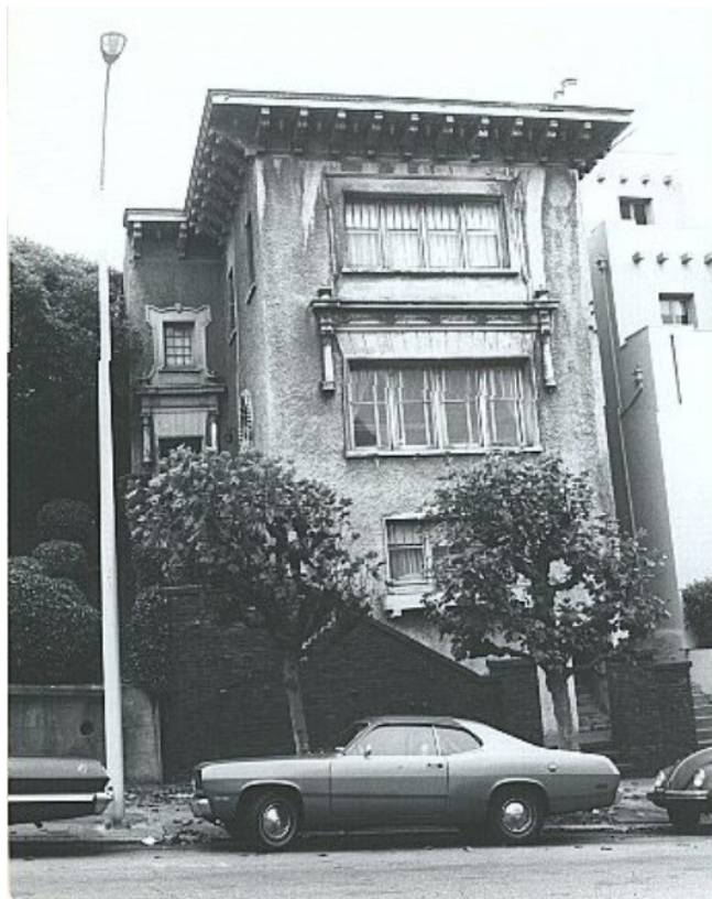
1976 DCP Survey photo.
