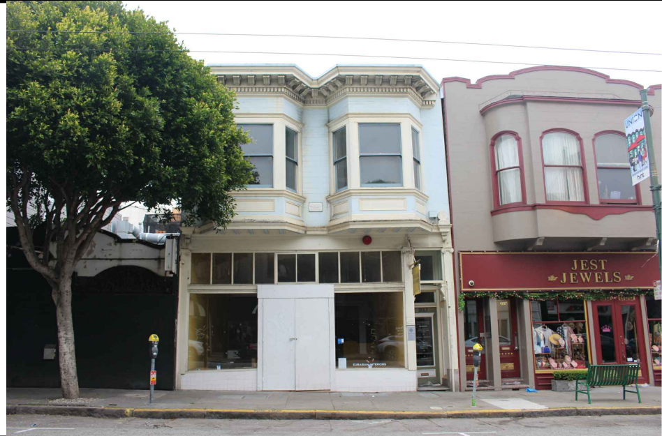
4 EXISTING STOREFRONT PHOTO SCALE: N.T.S.
