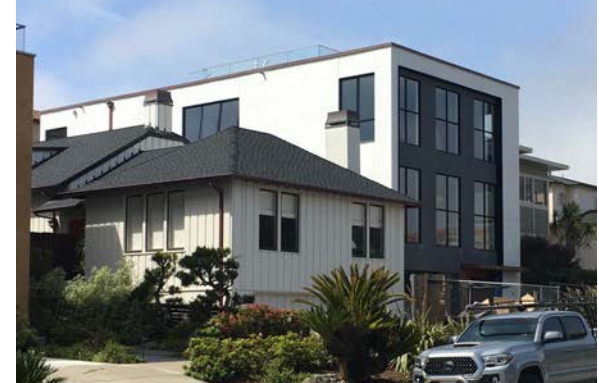
47. 255 SEA CLIFF AV (1951/2018) NEW CONSTRUCTION
