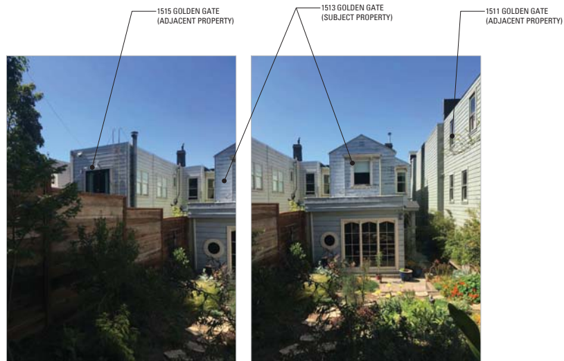
2 (E) SITE PHOTOS - BACKYARD VIEWS SCALE: N.T.S.
